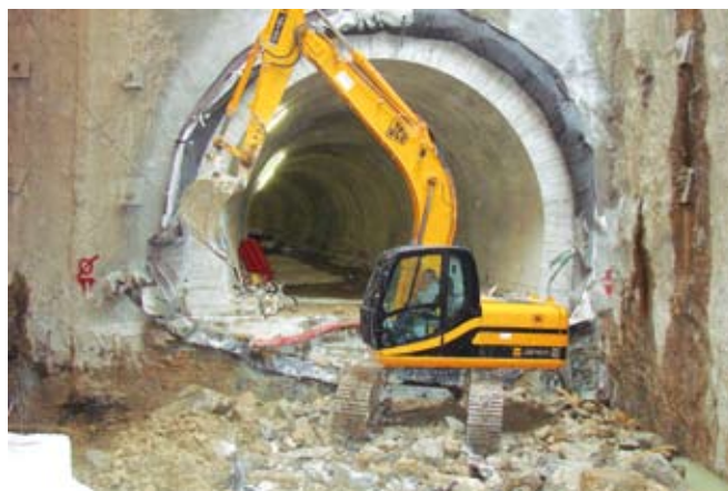
Lavori di scavo a Pozzo Brignole
