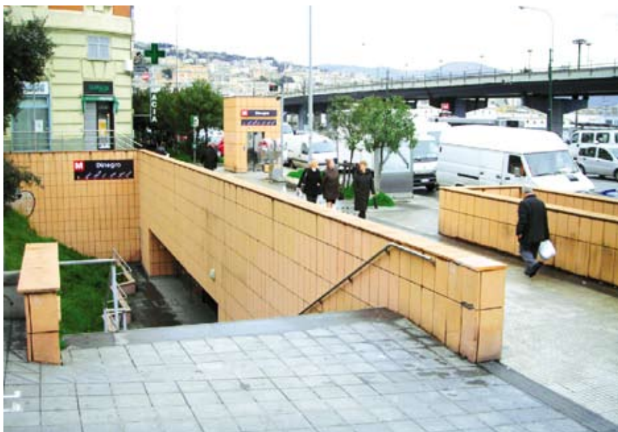
Stazione Dinegro, imbocco da Piazza Dinegro "lato monte"
