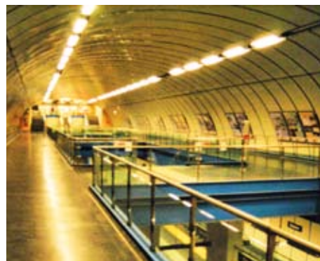
Stazione Darsena, particolare delle scale d'accesso alle banchine
