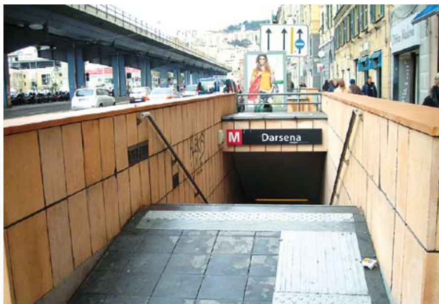
Stazione Darsena, imbocco dal lato Prè
