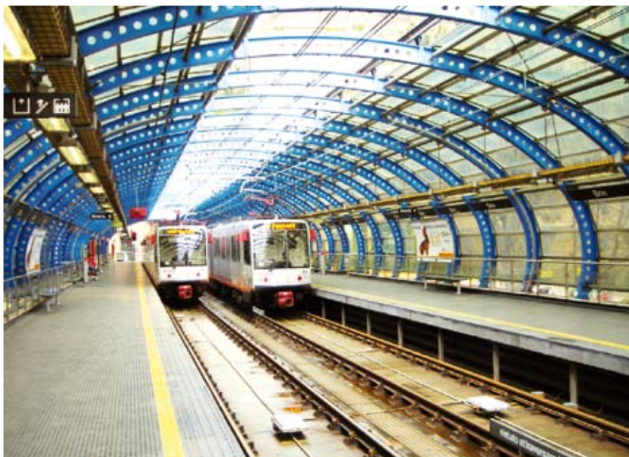
Stazione Brin/Certosa, particolare dell'arrivo/partenza dei convogli della metropolitana - vista dalla banchina
