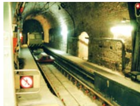
Stazione De Ferrari, particolare tratto terminale della tratta della metropolitana
