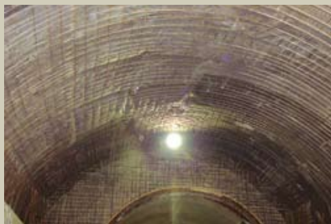
Particolare dell'armatura in calotta
