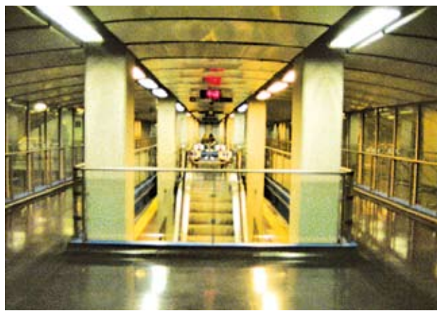
Stazione di San Giorgio, vista dal bordo banchina
