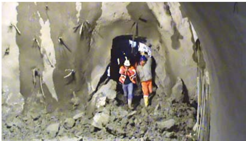
Abbattimento dell'ultimo diaframma della tratta De Ferrari Brignole in corrispondenza di P.zo Brignole
