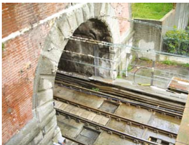
Galleria della Certosa, imbocco di Rivarolo
