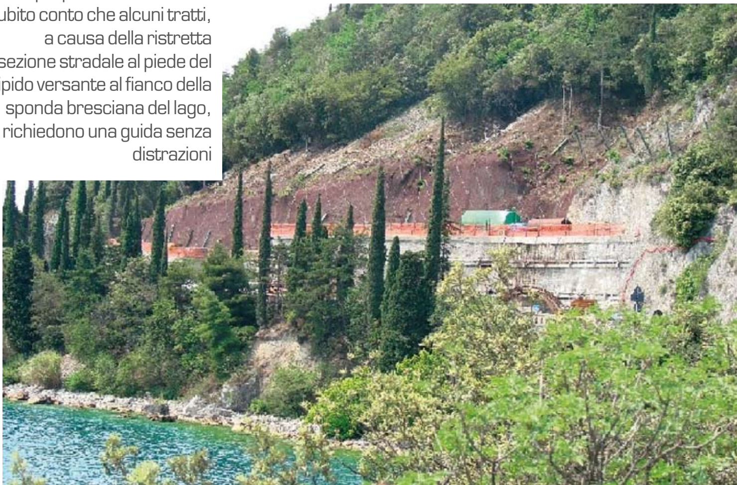
Opere di sistemazione del versante
