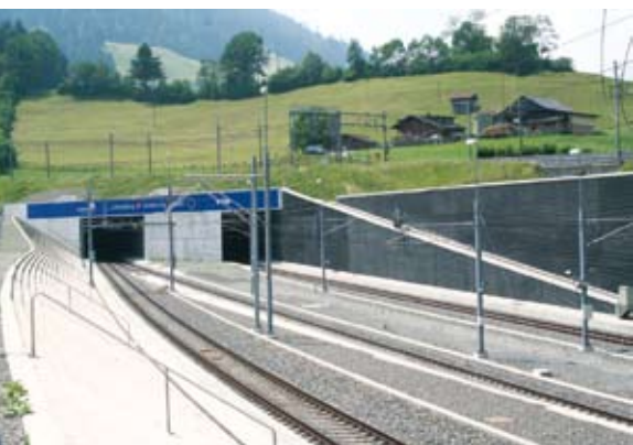
Imbocco Nord del Tunnel di base a Frutigen Fonte: http://de.wikipedia.org/wiki/L%C3%B6tschberg-Basistunnel
