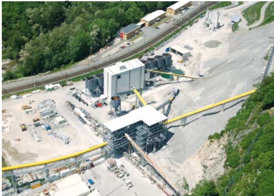
Area di cantiere a Sigirino - Fonte: www.alptransit.ch
