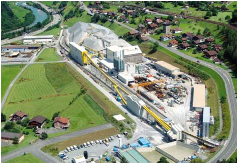
Impianto di preparazione dei calcestruzzo a Amsteg - Fonte: www.wikipedia.org
