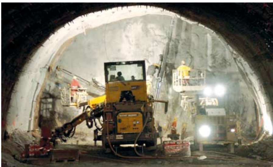
Lavori di perforazione al fronte con mezzi meccanici a Faido - Fonte: www.alptransit.ch
