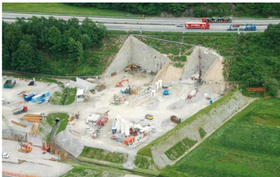
Camorino, visione laterale della zona del portale a Vigana - Fonte: www.alptransit.ch
