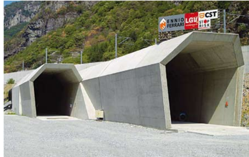
Realizzazione del portale della tratta a sud (Bodio) della Galleria di base del S. Gottardo di raccordo al tratto a cielo aperto di Biasca - Fonte: Alptransit S. Gottardo SA, 2005
