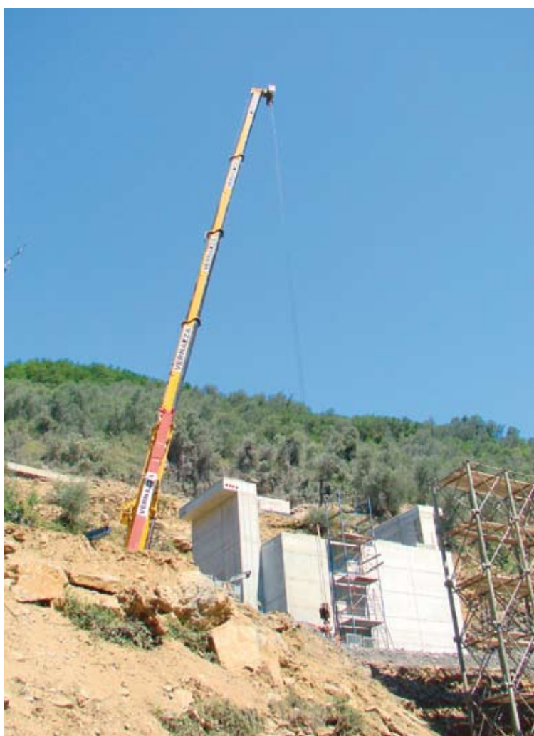
Realizzazione del Viadotto Rio Lavandero (torri di sostegno tipo S50 della Hünnebeck)
