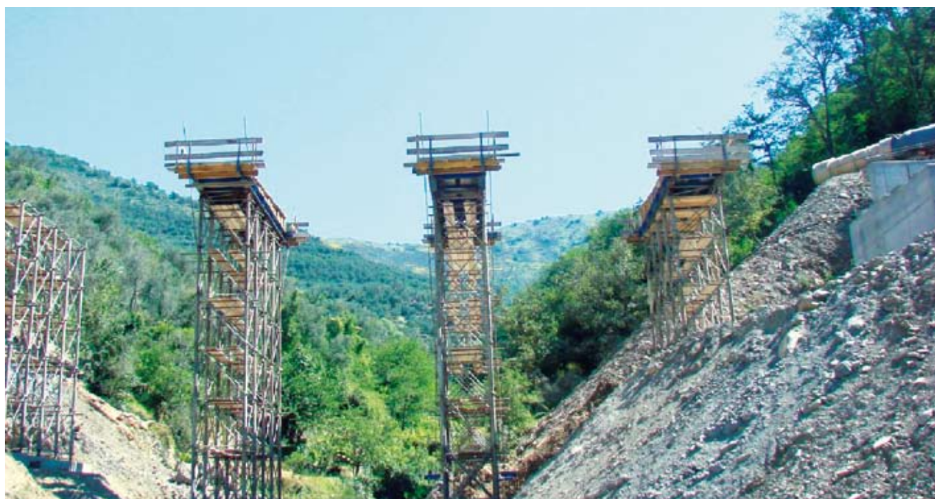
Realizzazione del Viadotto Rio Lavandero (torri di sostegno tipo S50 della Hünnebeck)
