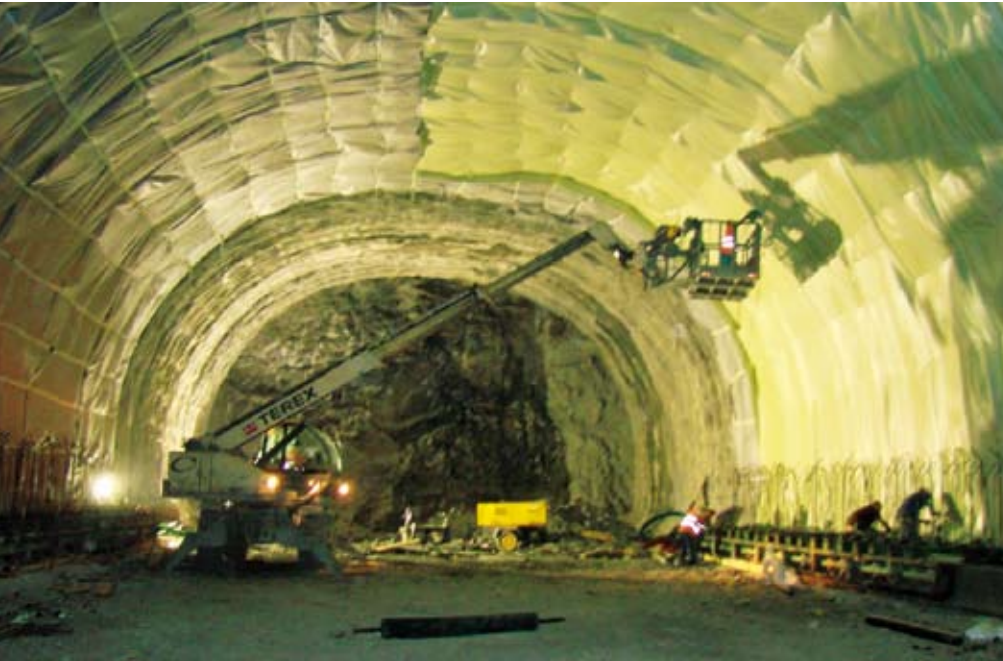
(in alto e a sinistra) Fasi di impermeabilizzazione della galleria Madonna dell'Uliveto
