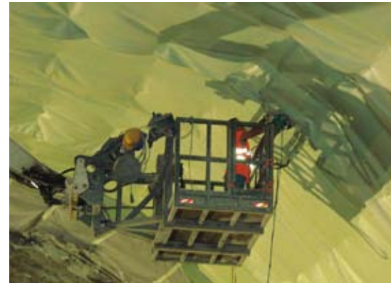
(in alto e a sinistra) Fasi di impermeabilizzazione della galleria Madonna dell'Uliveto
